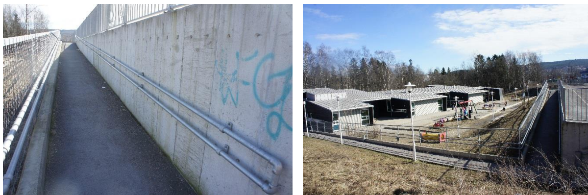
Figur 3 og 4, Betong og asfalt preger et langt inngangsparti. På bildet ses skjermingen mot trafikken på forsiden. Foto: Bente Fønnebo
